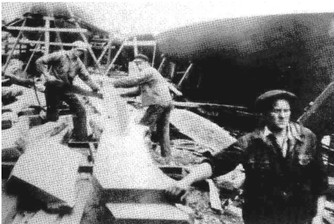
Georg Corneliusson och Allan Ahlberg kapar ekplank för spant.
