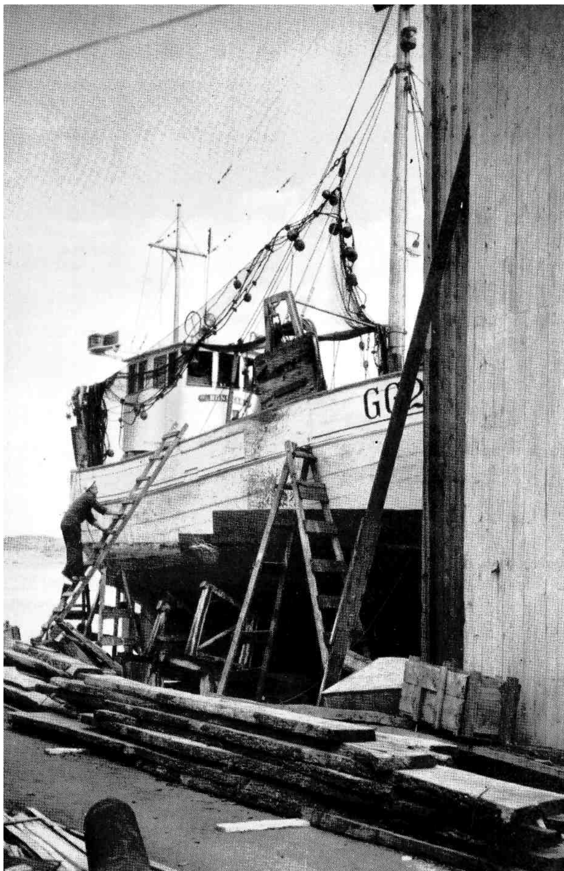
GG 25 "Rönnskär" byggd på Petters Varv år 1960. Här uppdragen på slipen vid båthuset för reparation.
