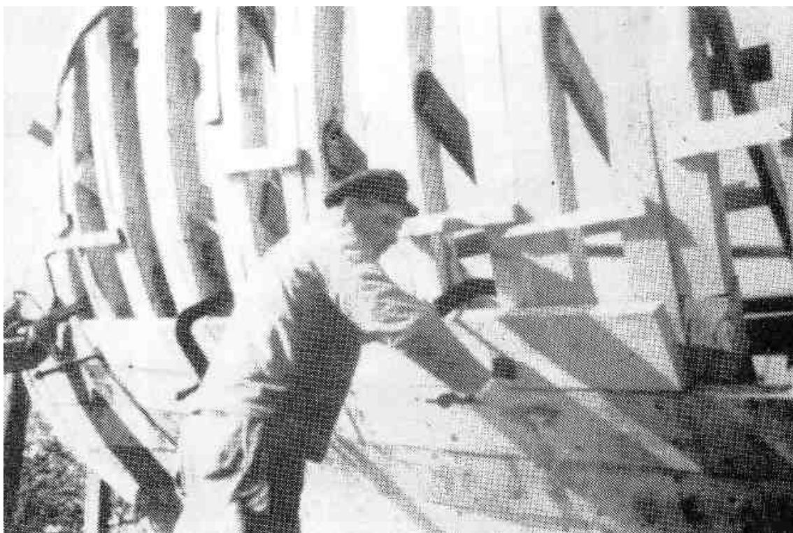
Skrutvting sätts fast.
