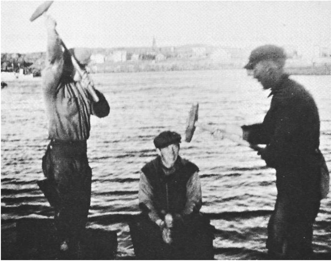
Här kan man se hur det borras för hand på flotten.
