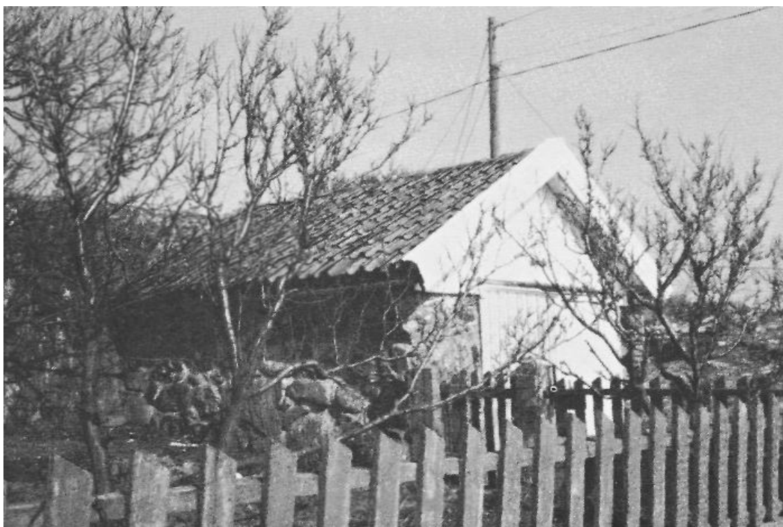
Olssons källarvind byggd vid bergvägg.
