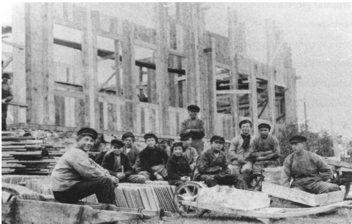
Nya skolan under uppförande 1920. Byggmästare Herman Tilländer till vänster. I förgrunden Olsson, Axel B., August H., Karl S., Hjalmar T., Gustav B., Fritiof S., Knut K., Gottfrid R. och August (Gottfrid) G.
