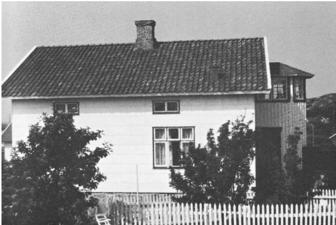
En väl bevarad femkantig trappkur med fönster runt om är Konrads i Halaberget. Huset byggdes 1907 och trappkuren 1914.
