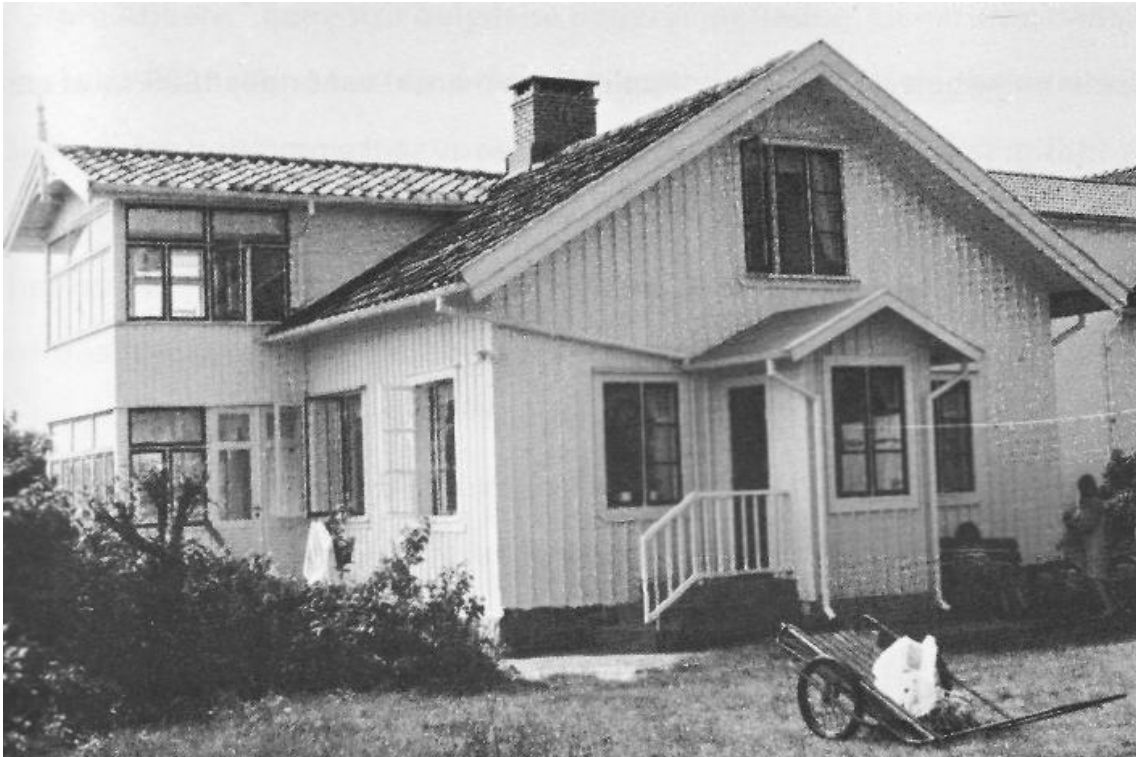
Ida och Oskar Olofssons hus, byggt på 1890-talet. Tillbyggt i olika etapper.
